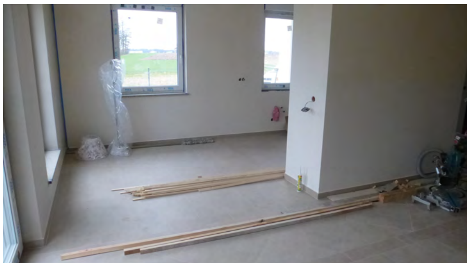
Abb. 6: Weitere Maßnahmen für eine saubere Atemluft im Hausinneren sind die Anwendung von natürlichen Lehmfarben auf allen Wänden und Decken anstatt chemischen Dispersionsfarben. Um die Hausstaubbildung zu reduzieren wurden Keramikböden im Erdgeschoß verlegt. Diese haben zudem den Vorteil das sie sich weder elektrostatisch aufladen noch chemische Substanzen wie Formaldehyd o. ä. an die Raumlufzt abgeben wie bei modernen Fußbodenbeläge aus Laminat und Polystertepptichen.
