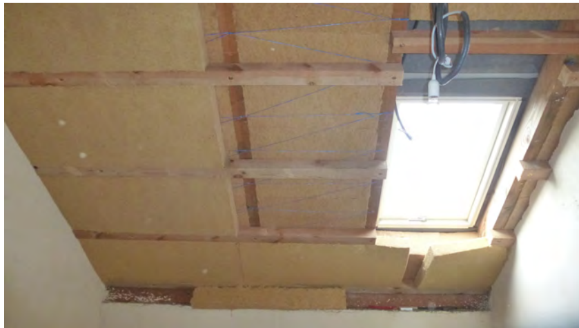
Abb. 2 + 3: Wärmedämmung im DG mit 2 Lagen Holzfaserplatten im Innenbereich sind Bestandteil des Konzeptes um eine gute Raumluft zu erzielen
