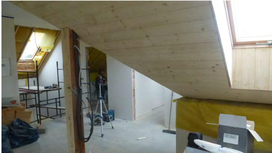
Abb. 4 + 5: Auch der weitere Ausbau im Dachbereich mit Massivholzpanelen wird zu einer sehr guten Raumlufzt beitragen. Die Holzoberfläche bleibt offenporig um die Raumfeuchte besser zu regulieren.
