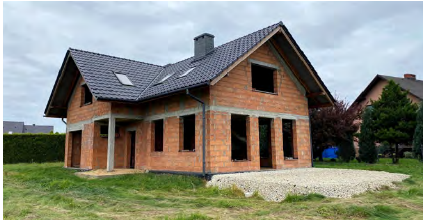
Abbildung 1: Ausführung des Rohbaus mit dem baubiologisch günstigen Ziegelstein für Aussen- und Innenmauern. Da Ziegelstein offenporig ist werden Luft und Feuchtigkeit im Hausinneren besser reguliert.
