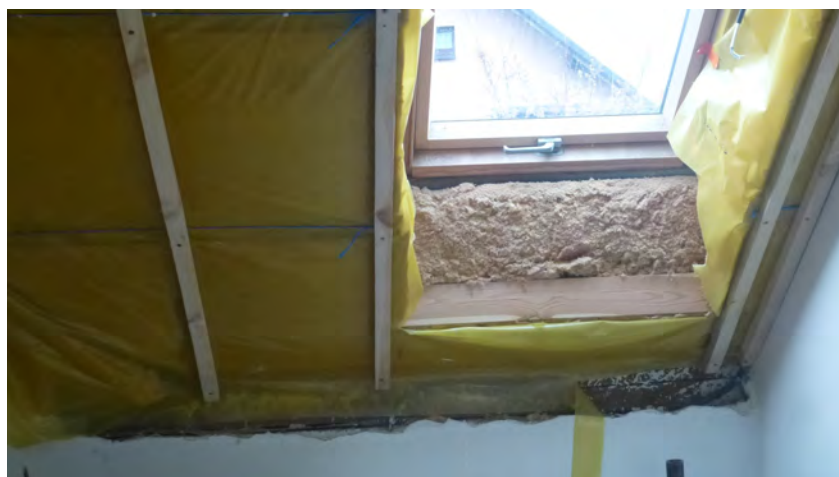
Abb. 2 + 3: Wärmedämmung im DG mit 2 Lagen Holzfaserplatten im Innenbereich sind Bestandteil des Konzeptes um eine gute Raumluft zu erzielen
