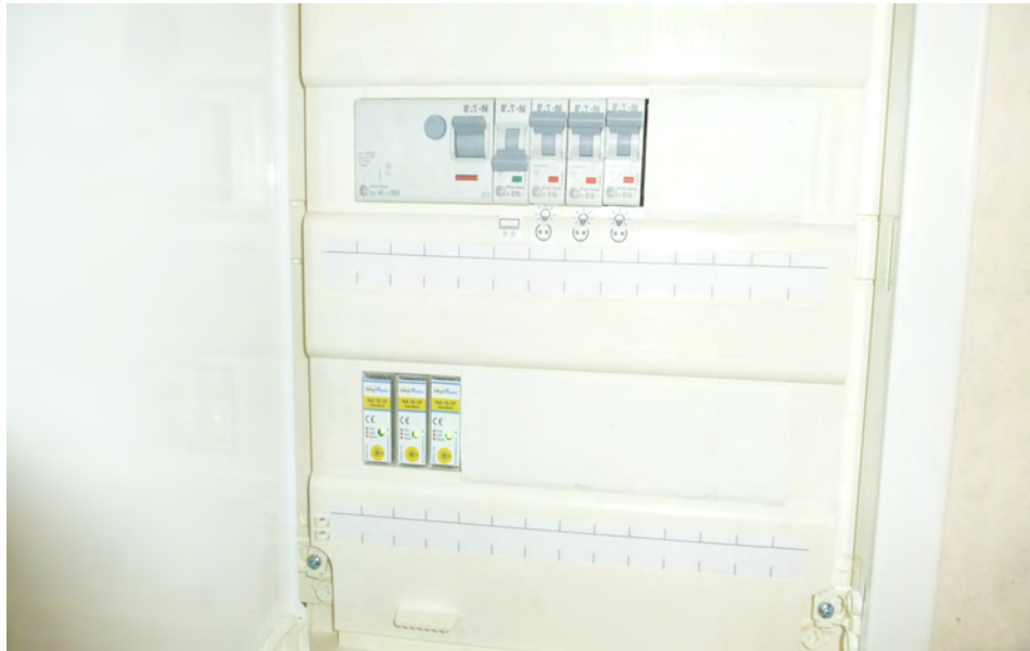
Abbildung 7: Elektrische Unterverteilung im Dachgeschoss. In der obere Reihe befindet sich der FI-Schutzschalter. Gute Investition für Personen- und Geräteschutz. In der unteren Reihe 3 Netzfreeschalter die das gesamte Geschöß während der Zeit des Schlafens von der 230 Volt Netzspannung freischalten. Somit ist tiefer, erholsamer Schlaf für alle Familienmitglieder gewährleistet.
